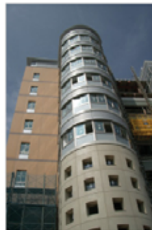
研究教育棟(2): 1 棟妻側壁面
