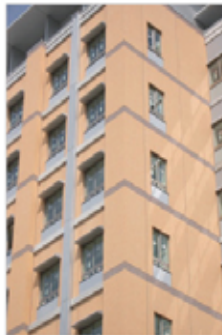
研究教育棟(1): 1 棟壁面
