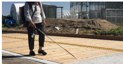
視覚障害者を基点にした木製バリアフリー歩道(★) 視覚障害のある人による歩車道境界の識別性向上に関する実証実験
