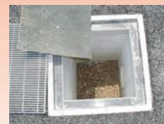
雨水浸透樹 透水性舗装と浸透トレンチで浸透しきれなかった雨水を地下に浸透させる。キャンパス内に2000個設置する計画。
